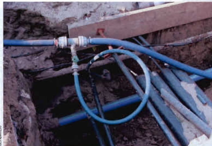
Abb. 4: Notwasserversorgung mit Schläuchen
