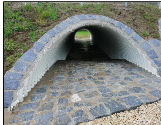
Bild Durchlass mit Schwelle
