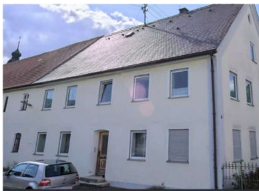
Bild 7: IO7 (Wohnhaus Bauherr) zur Information
