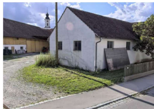
Bild 8: Planungsgrundstück mit Bestandsgebäude (Abrissgebäude)
